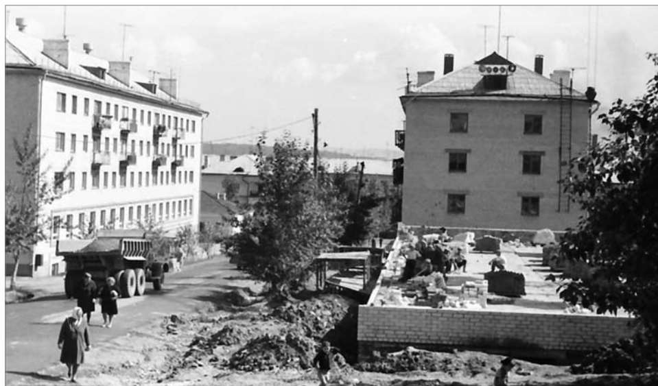
Строится кафе «Садко».
