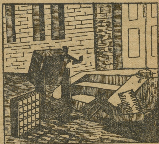
Установка В. Б. Вейнберга.
