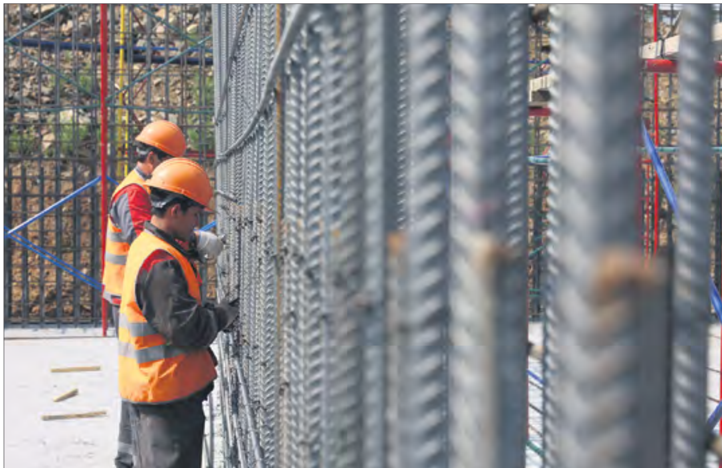
Сейчас строители вяжут армокаркас будущих очистных. Работают пока в одну смену, но для того, чтобы нагнать упущенное время, возможно, введут еще одну. // Фото Владимира Коцюбы-Белых
