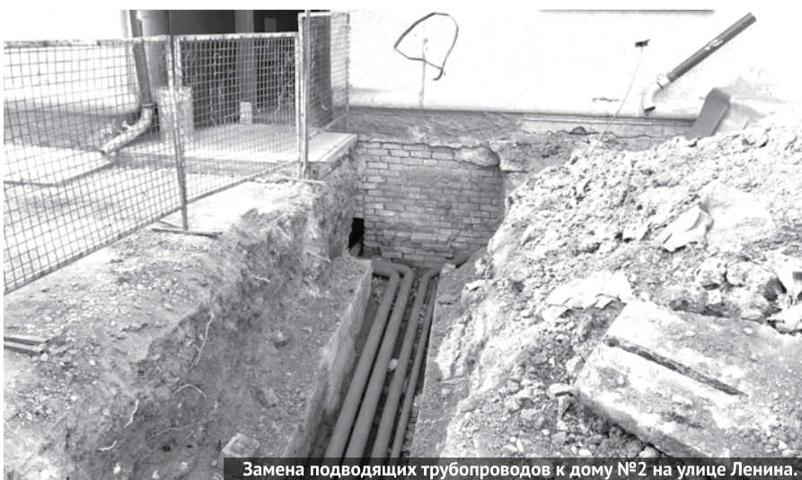
Замена подводящих трубопроводов к дому №2 на улице Ленина.
