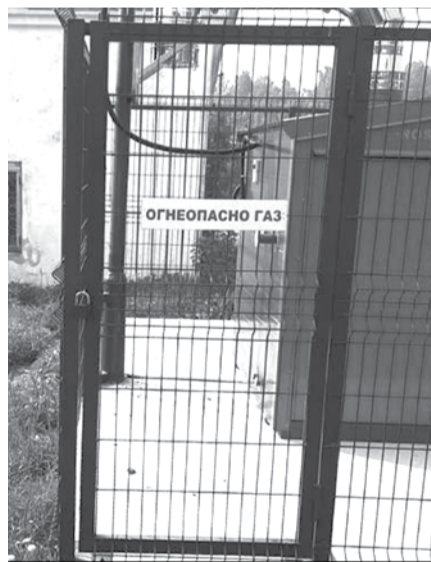
Установка котла наружного размещения котельной села Байны на улице Рудничной.
