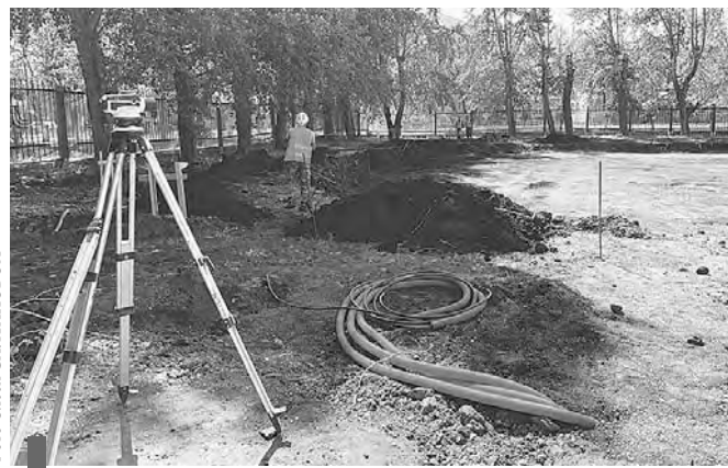
Площадка будущего корта на стадионе «Олимпик»
