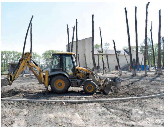
Кронирование завершено, площадки готовят к укладке плитки и асфальта
