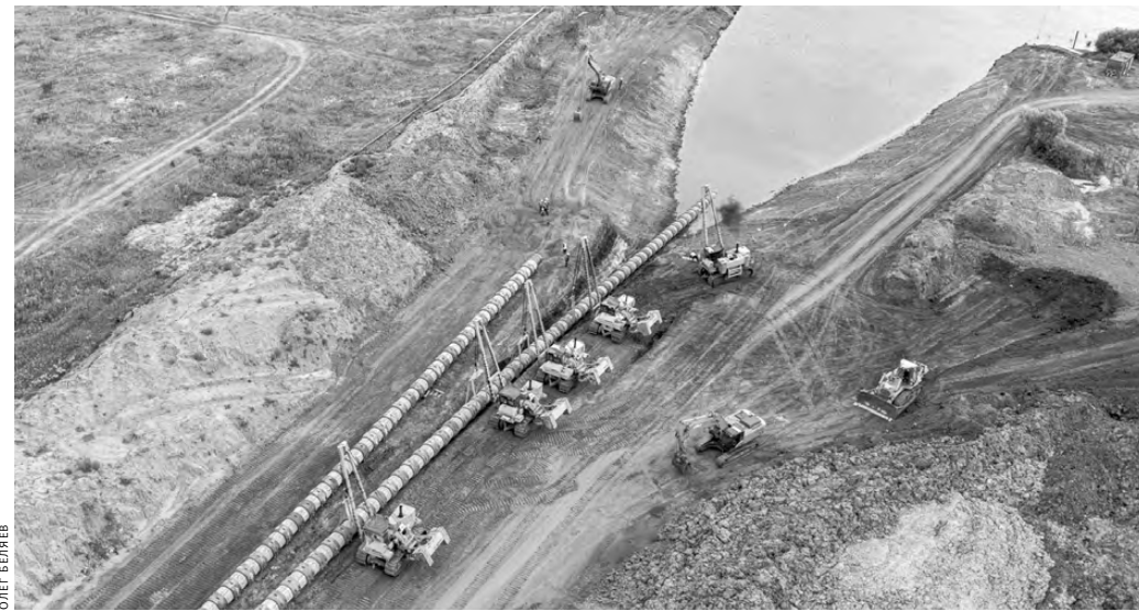
Только в 2022 году заменены 12 участков трубопроводов общей протяженностью 68 километров.
