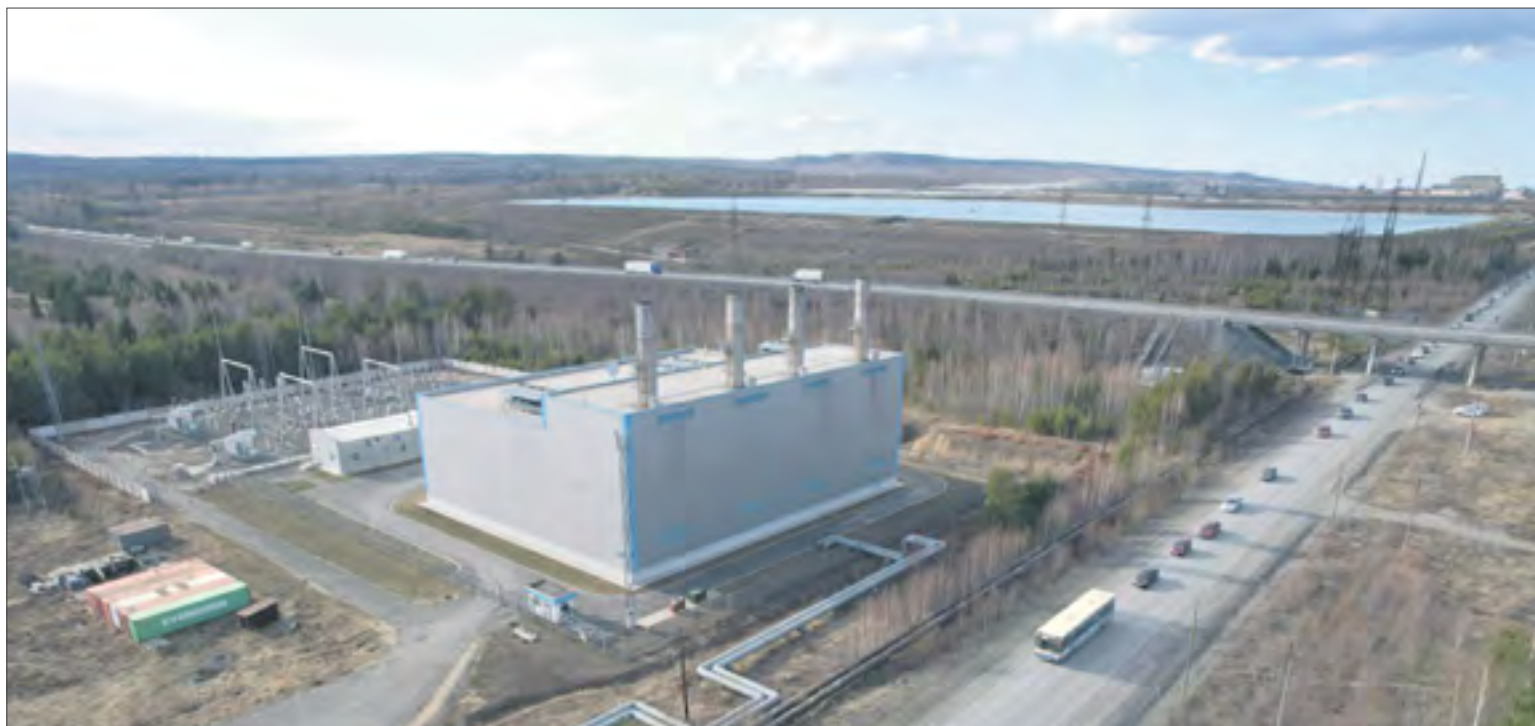
Чтобы совсем избавиться от перегрева, нужно решить еще массу проблем, главная из которых — инертность системы отопления Ревды. На фото — газотурбинная станция. С нее поступает тепло, которое, например, сейчас, когда на улице уже устойчивый плюс, нельзя снизить, так как сразу же во многих домах снизится температура горячей воды. // Фото Владимира Коцюбы-Белых
