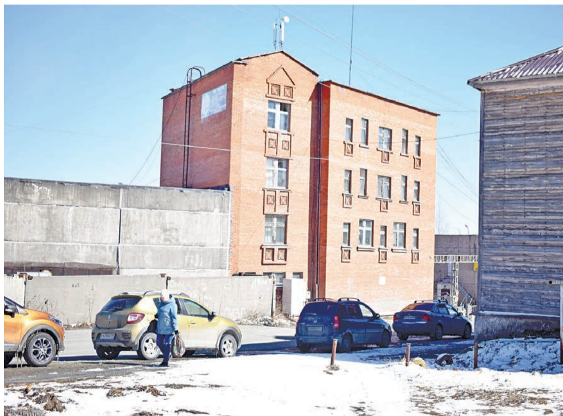
Разговоры о приватизации МУП «Горэнерго» ведутся давно
