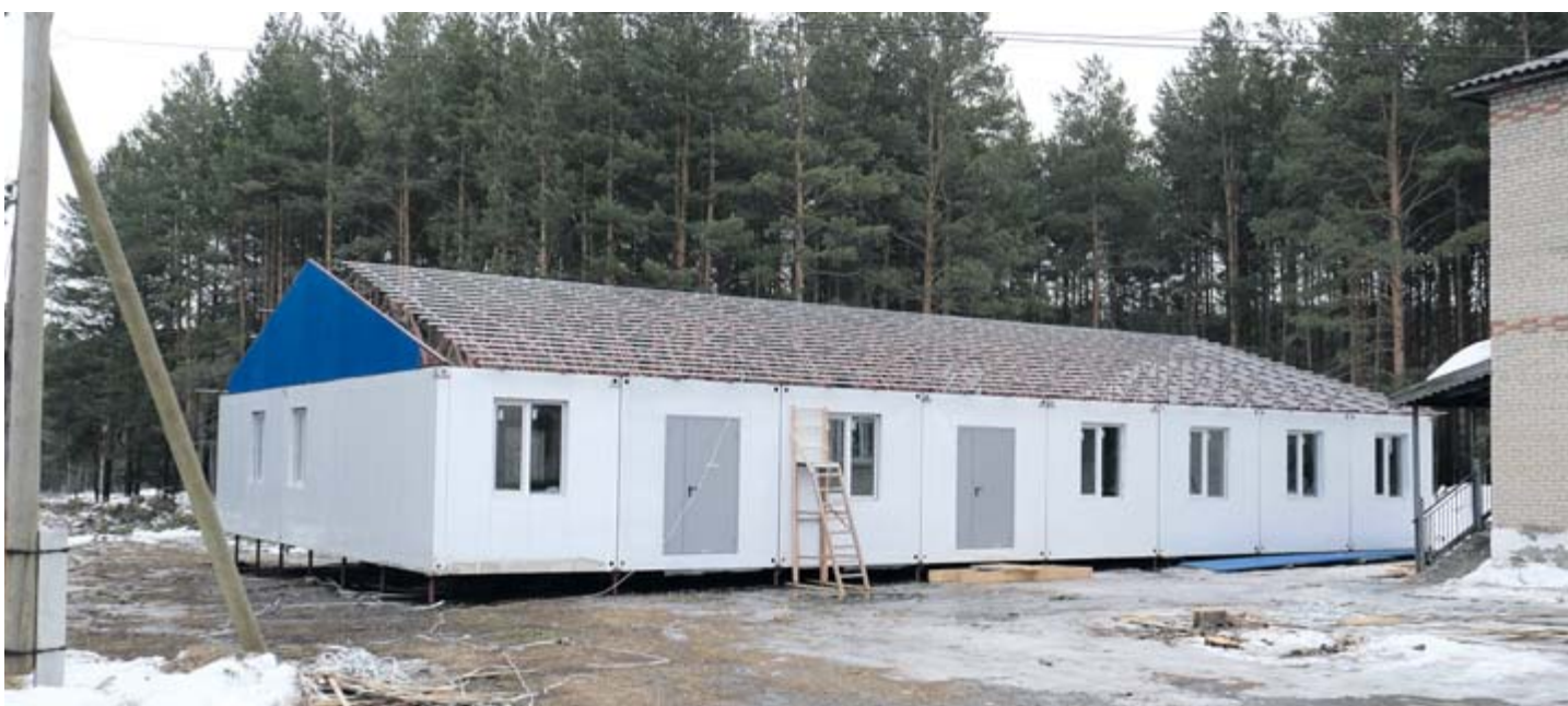
Подрядчик приступил к строительству крыши на ОВП в посёлке Асбестовском
