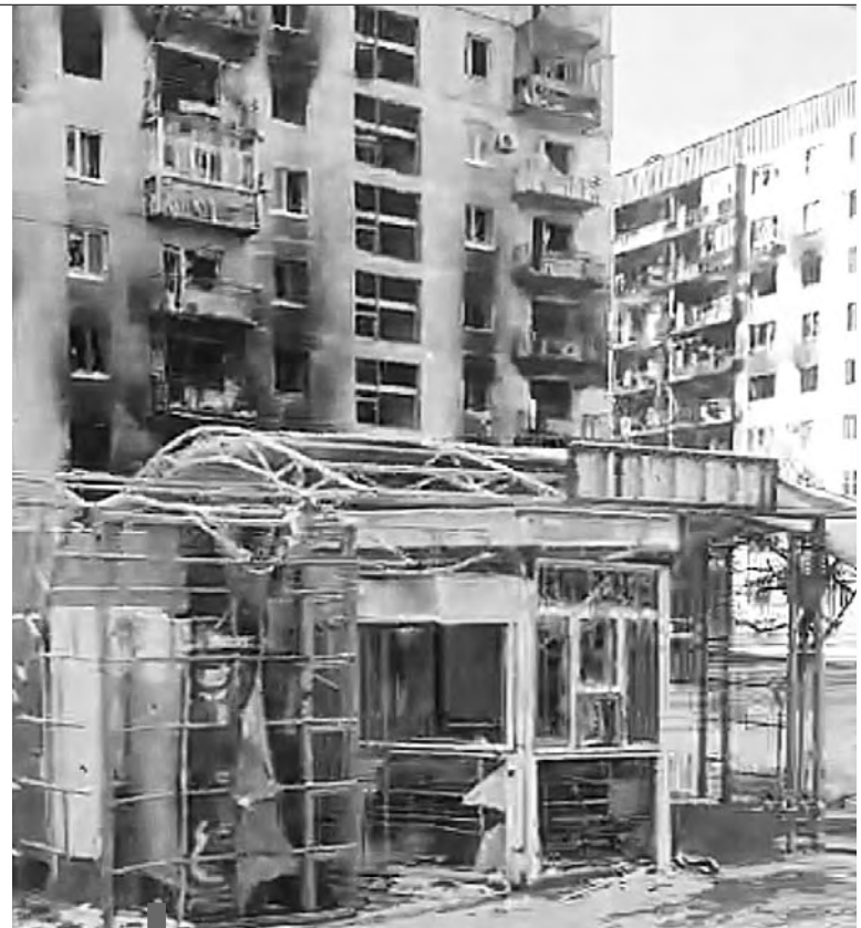
Северодонецк: полуразрушенные дома и пустынные улицы
