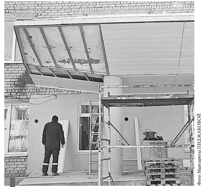
Работы идут одновременно и внутри здания, и снаружи
