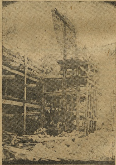
Под'ем вагонетки со стройматериалами под'емным краном.
