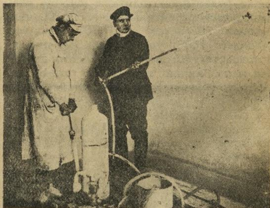
Машина „Краснобуль“, которой в течении 8 час. можно выбелить 250 кв. метров, вместо 60, как это бывает при ручной побелке. Машина эта сейчас в ходу на некоторых постройках. Рабочие строители о „Краснобуле“ отзываются очень хорошо.
