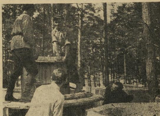
**Разборка форм на бетонном заводе.**
