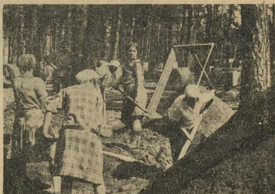
**Просеивают песок на бетонном заводе.**
