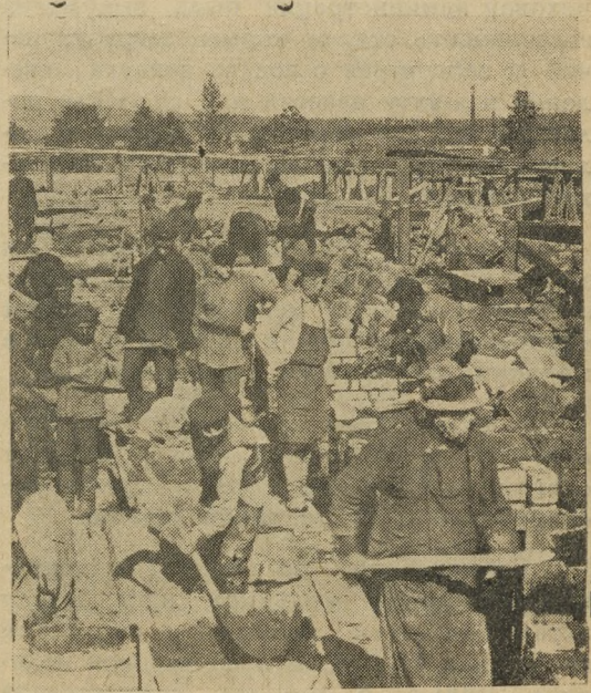
Стены нового химического завода растут.
