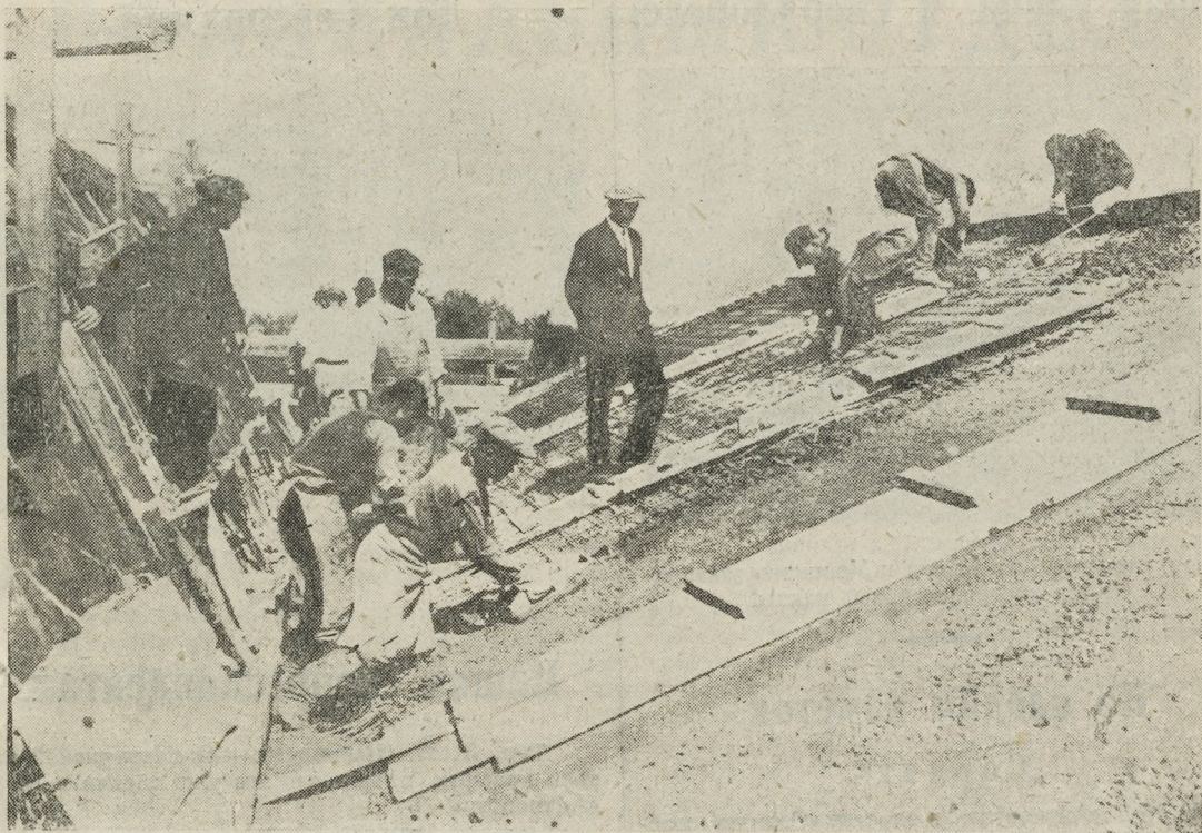
Заканчивается бетонирование крыши вновь строящегося трамвайного парка.
