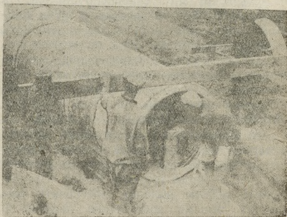
В лесу, около Исетского пивзавода, прокладываются канализационные трубы.
