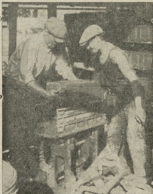
Рабочие строители прессуют шлак-бетонный кирпич на стройке «Дома промышленности» в Свердловске.
