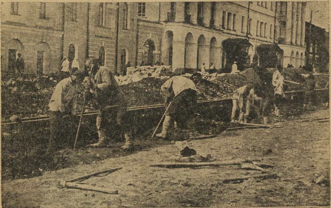
Работы по прокладке трамвайной линии в Свердловске развернуты полным ходом.
