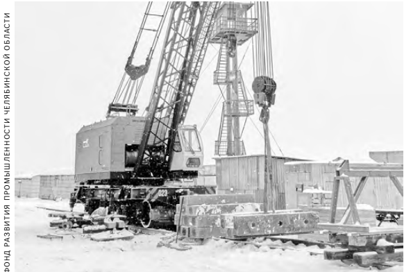
Небольшой и маневренный кран незаменим при работах на заводских путях.
