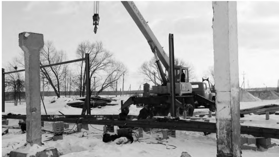
На стройке отдельного молочного блока.
