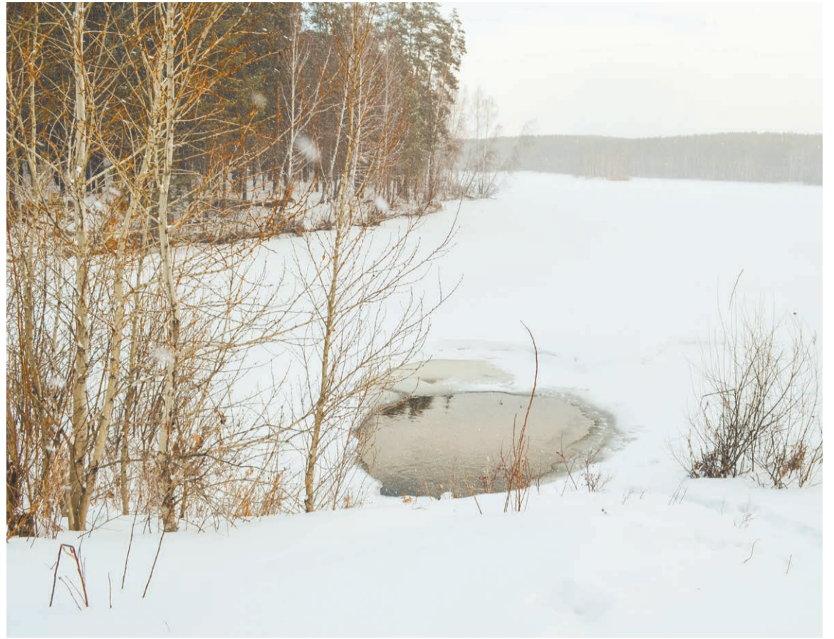
В планах МКУ «Благоустройство и ЖКХ» расчистка отводящего канала донного водоспуска ГТС Шиловского пруда (нижнего), который вызывает нарекания у жителей
