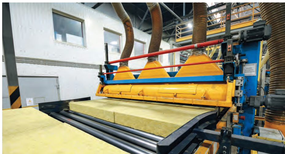
Система аспирации производственной линии № 3
