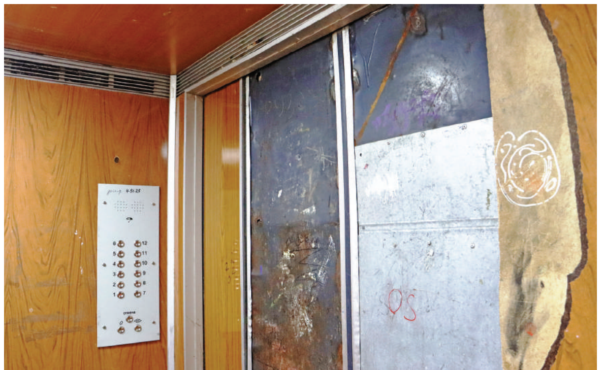
Грузовой лифт Ленина, 71 давно ожидает ремонта.
