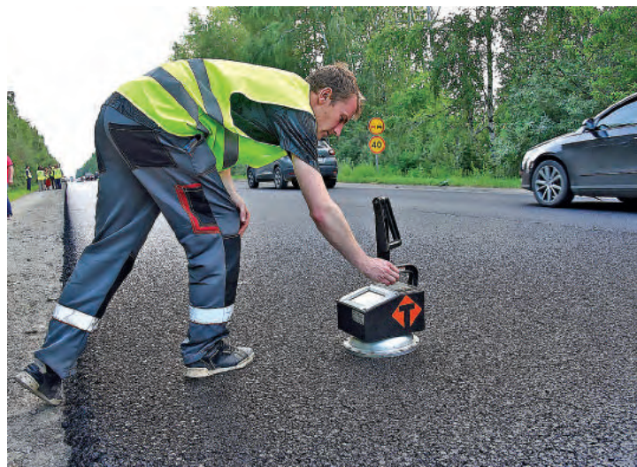
Дорожное покрытие измеряется специальным асфальтобетонным плотномером.
