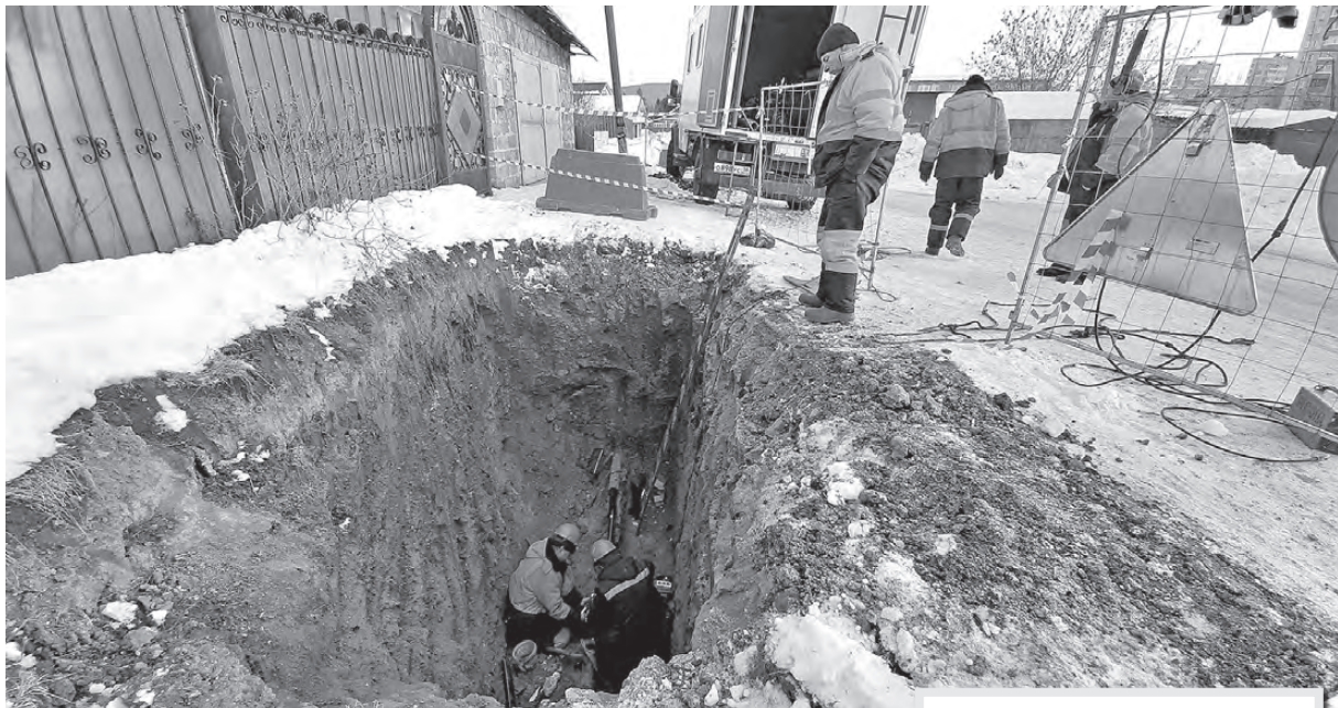
Устранение порыва по ул. Павлика Морозова.
