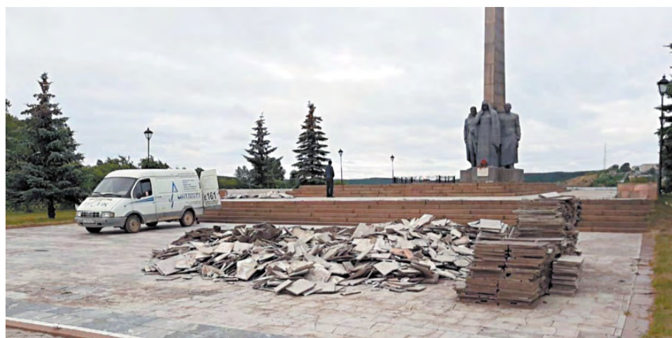
Специалисты компании проводят ремонтные работы на площади у Мемориала боевой и трудовой славы.
