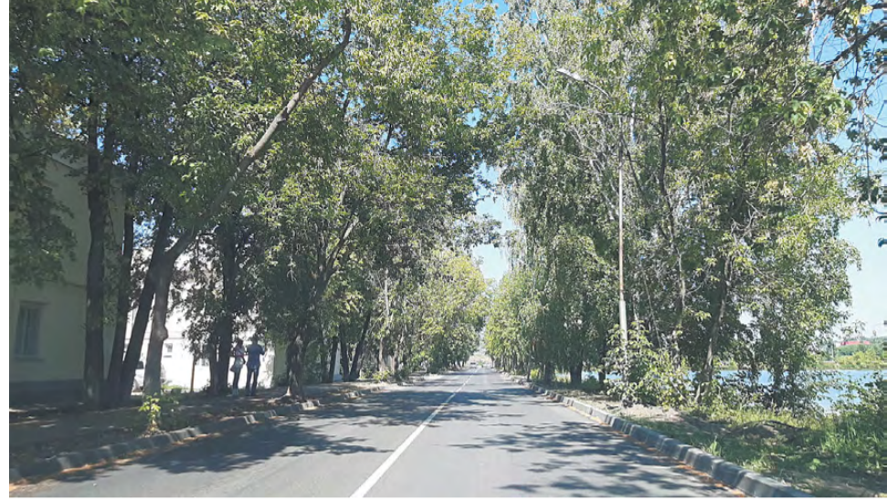
Ремонта этого участка ул. П. Морозова очень ждали.
