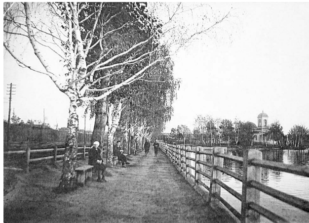
Городская плотина до реконструкции, 1930-ые гг.
