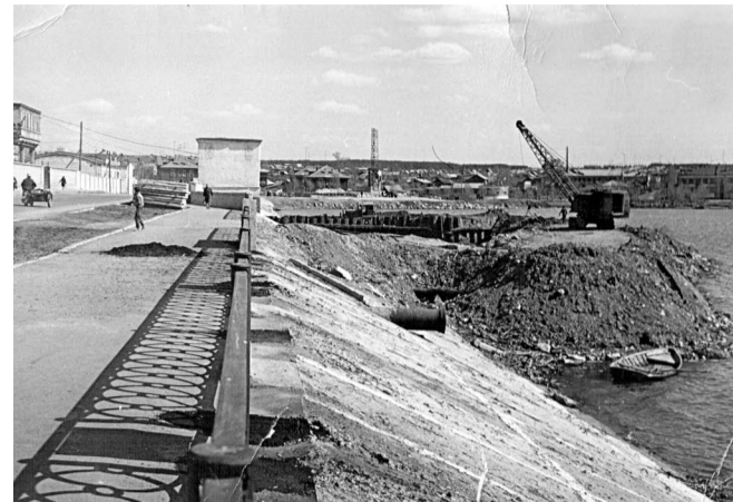
Ремонт плотины, 1960 г.
