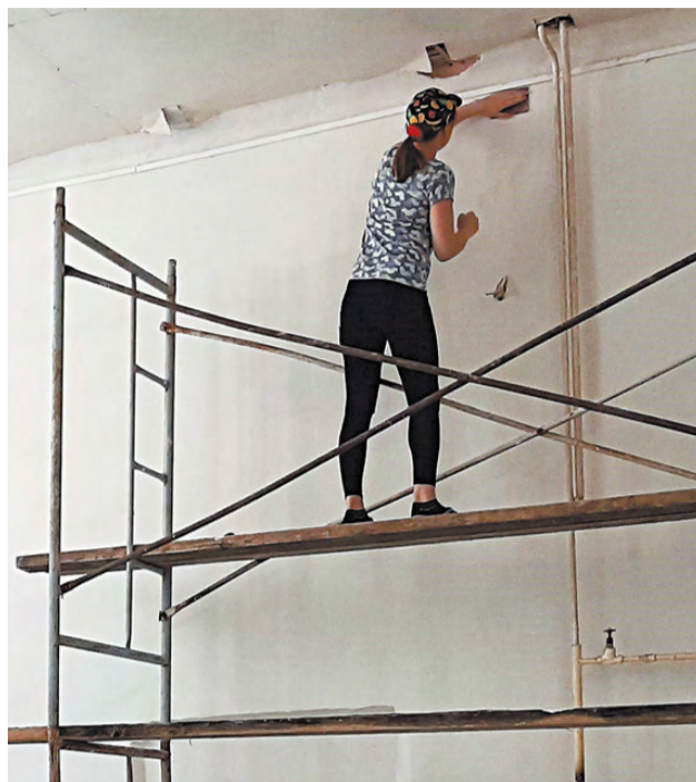
В школе №5 идут работы по ремонту спортивного зала.
