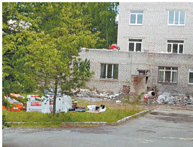
Ремонт кровли на переходе.
