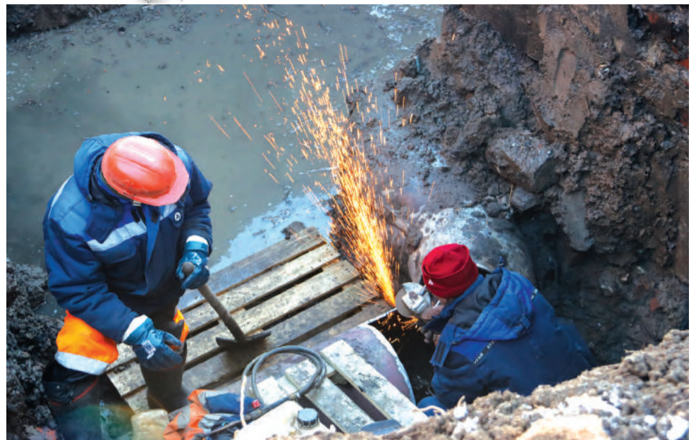
Зачистка вырезанного участка трубопровода для дальнейшей сварки.
