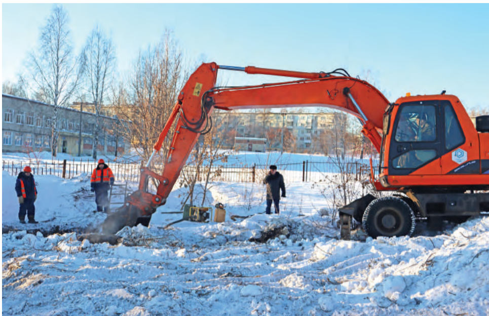
Во время земляных работ главное – найти порыв и не повредить другие коммуникации.
