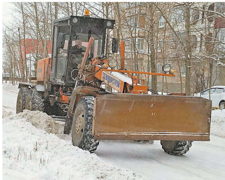
Трудится бригада Тагилдорстроя.
