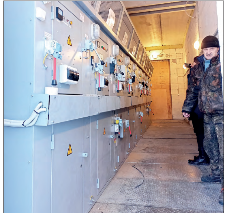
Один из двух новых трансформаторов
