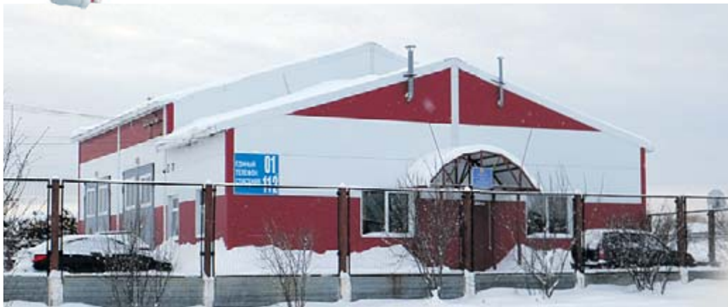
Пожарная часть в селе размещается в специально построенном здании
