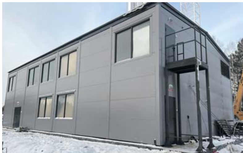
В Верхней Синячихе завершено строительство газовой котельной мощностью 40 Мегаватт
