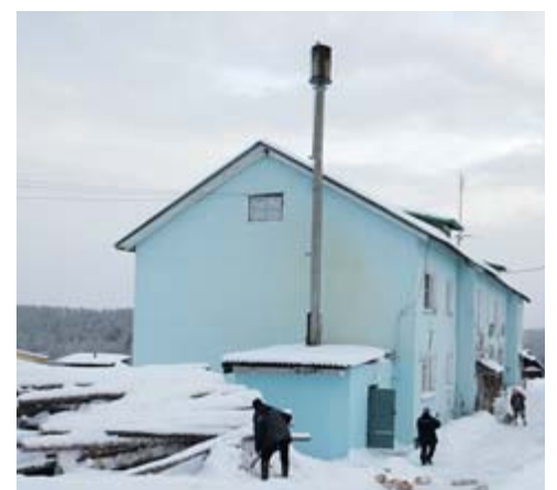
Единственный в селе многоквартирный дом имеет свою котельную
