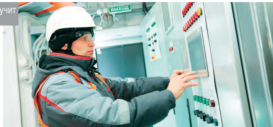
Чтобы смонтировать здание закрытого распределительного устройства 10 кВ, силовые трансформаторы 110 кВ, элегазовые выключатели, разъединители, ограничители перенапряжения, трансформаторы тока 110 кВ, мачты освещения и связи, Свердловэнерго понадобилось менее года
