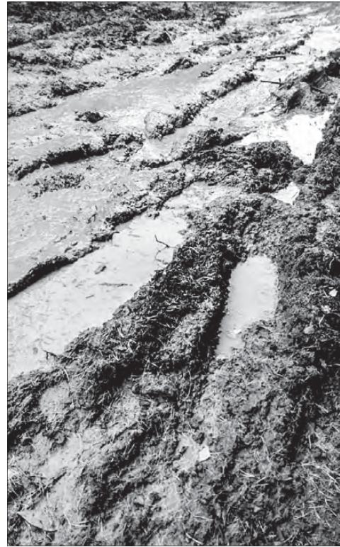
Так выглядела дорога на Большую Лавровку уже после ремонта. Фотографии нам прислала Надежда Балабанова
