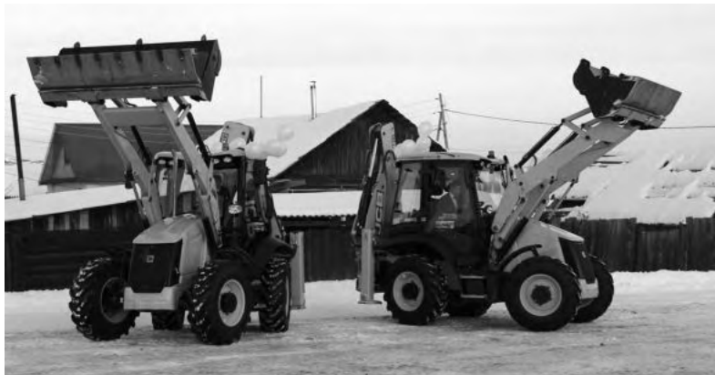
«Вальс» техники, задействованной в строительстве газопровода.
