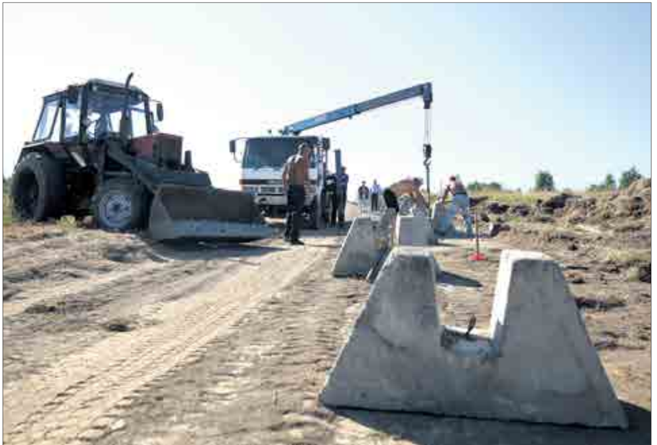
Сейчас рабочие устанавливают опоры будущего забора и это самая сложная часть процесса. // Фото Владимира Коцкобы-Белых
