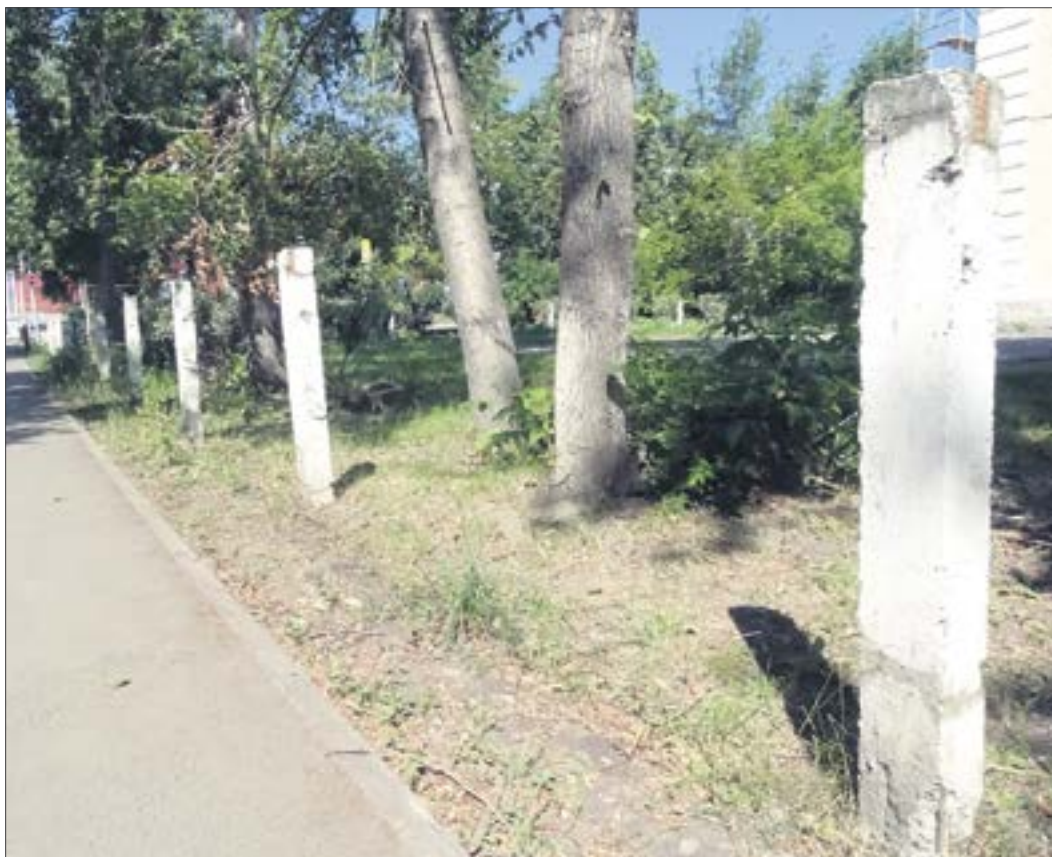
Первое, что заменят у школы — забор. Он уже демонтирован по всему периметру здания. // Фото Александра Зиновьева
