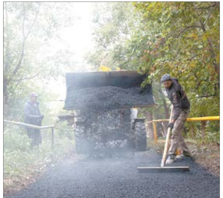
На пешеходной дорожке горячий асфальт распределяли вручную — специальная техника сюда проехать не может. А вот выравнивали покрытие при помощи катка. // Фото Владимира Коцюбы-Белых
