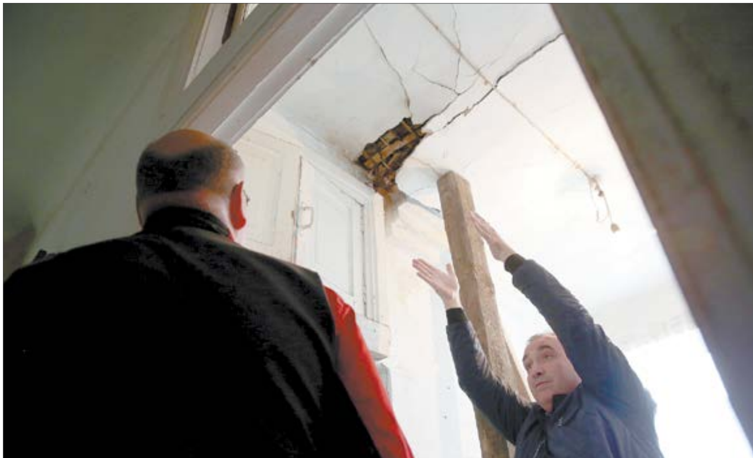
Андрей Мокрецов показывает Алексею Силачеву, где нужно будет поставить опоры. Одна здесь уже стоит — она появилась, когда потолок только начал оседать и трескаться. // Фото Владимира Коцюбы-Белых
