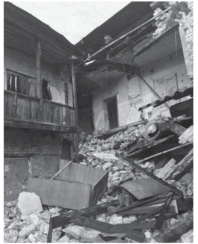
домами с нарушением лицензионных требований).
