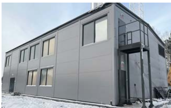
Здание новой котельной
