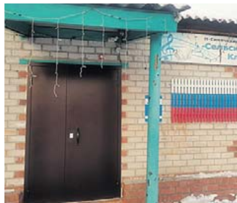
Заменяли входные двери в Нижнесинячихинском сельском клубе
