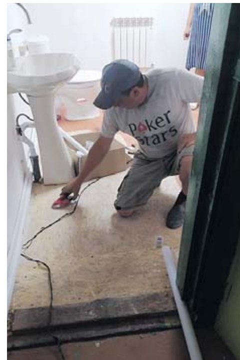
Ремонт в Ключевском сельском клубе
