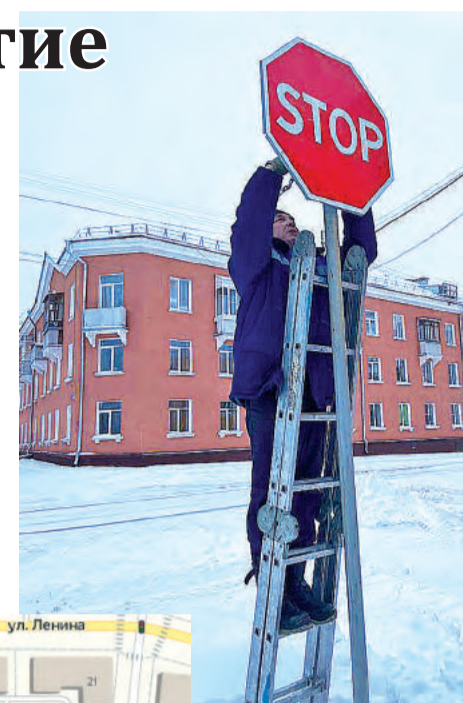
Установка временных дорожных знаков по улице Пушкина.
