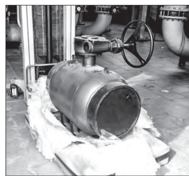
На Бажова, 11, сейчас проводятся работы по замене запорной арматуры. Новая задвижка весит почти полцентнера
