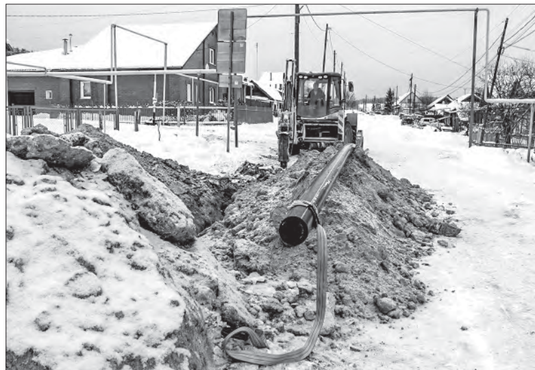
Земляные работы и укладку газопровода ведёт АО «Газмонтаж»
