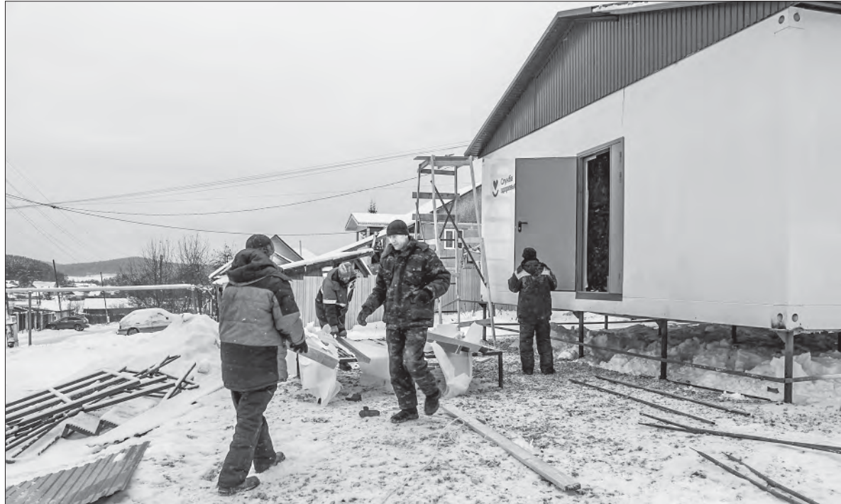
Модульное здание фельдшерско-акушерского пункта монтируют в центре села
