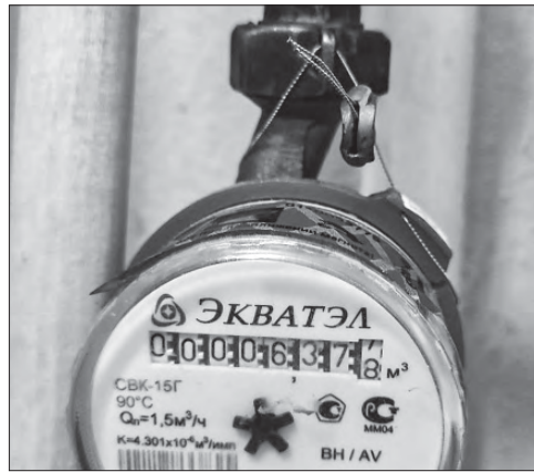
Контролёры сверяют показания индивидуальных приборов учёта с переданными цифрами и устанавливают антимагнитную пломбу
