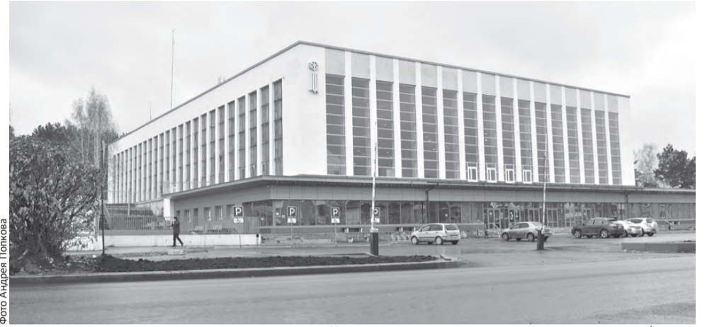
Нынешнее время – после капитального ремонта фасада
