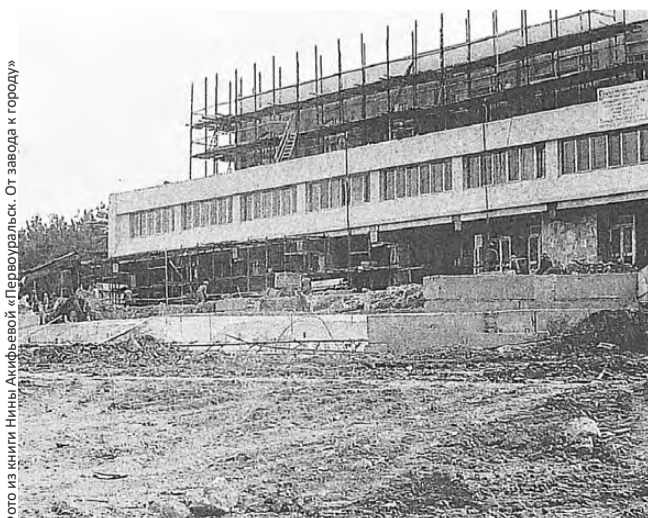
Строительство ДВВС в середине 1980-х
