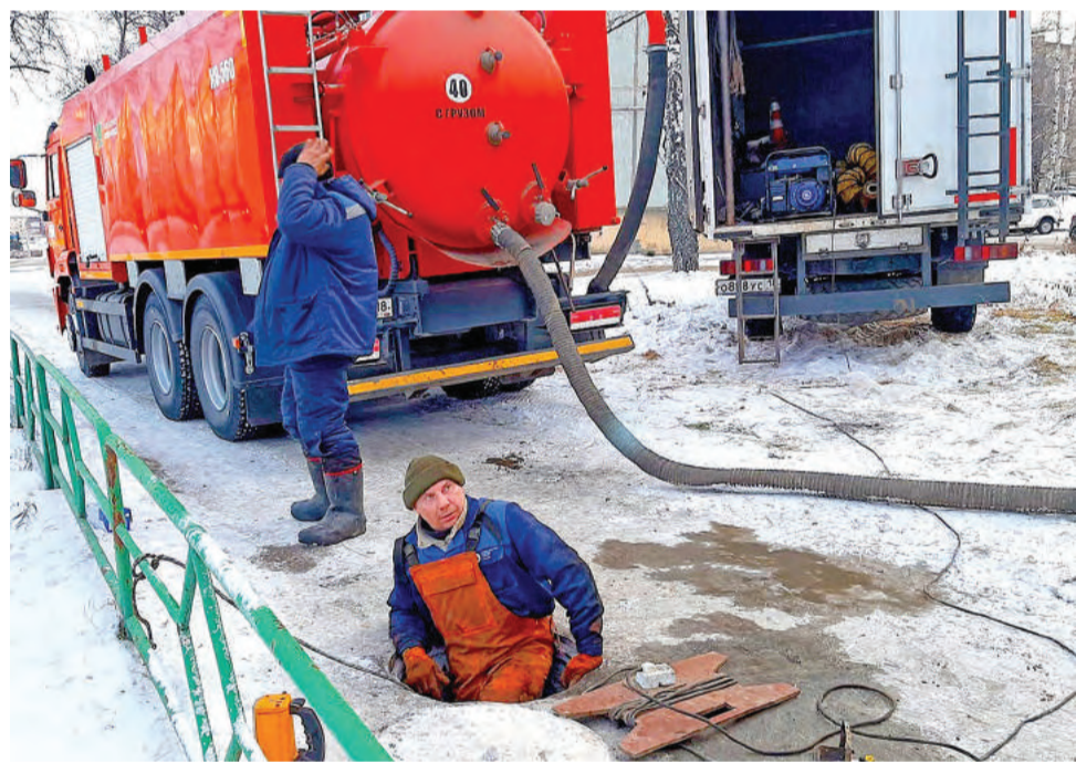
Ремонтная бригада на аварийном водопроводном узле.
