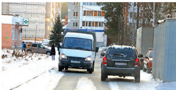
С начала строительных работ проезд вдоль дома № 102 по улице Ленина сузился ещё больше.
