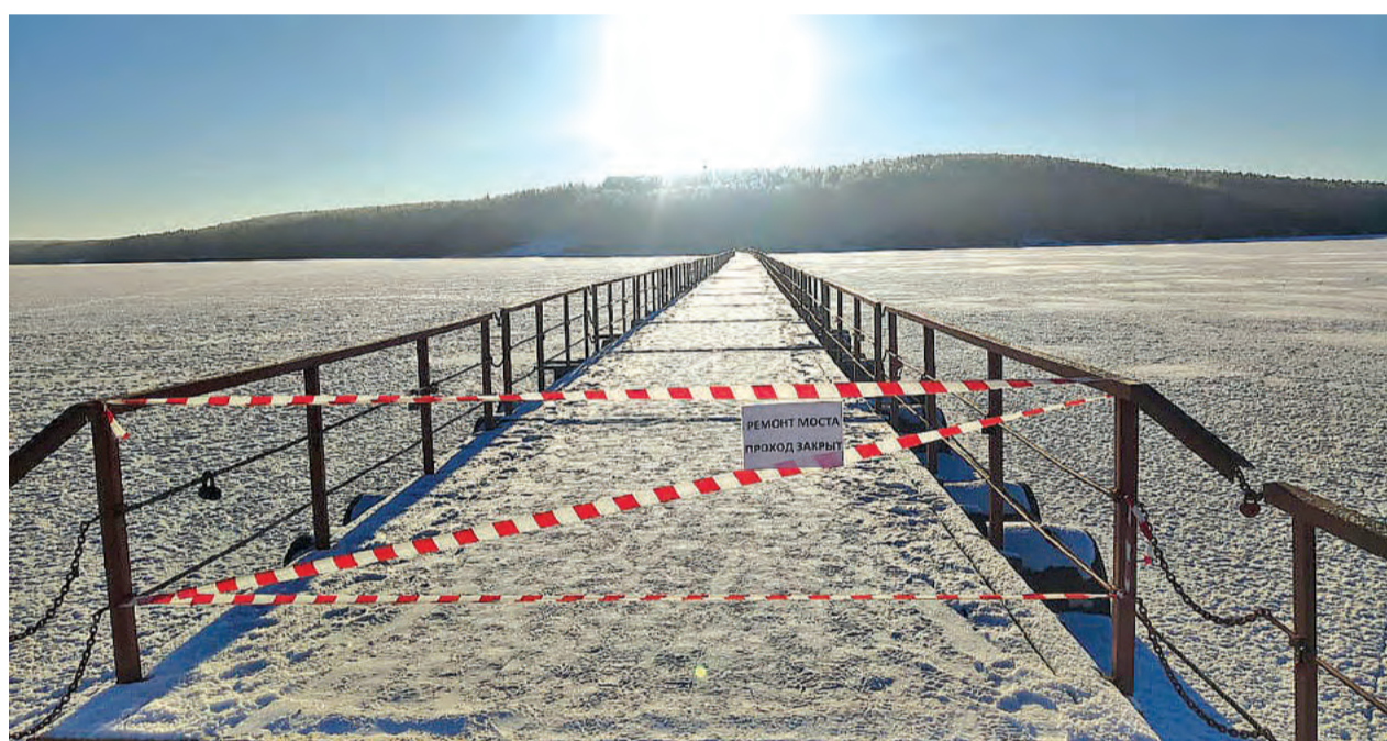
УГХ просит воздержаться от пеших прогулок по понтонному мосту на время ремонтных работ.
