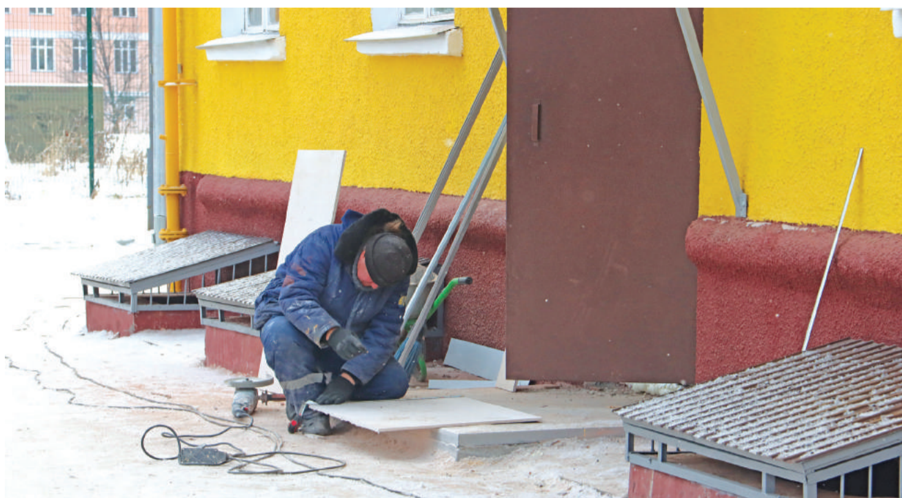
Ремонтные работы в первом подъезде дома № 45 по ул. Белинского.
