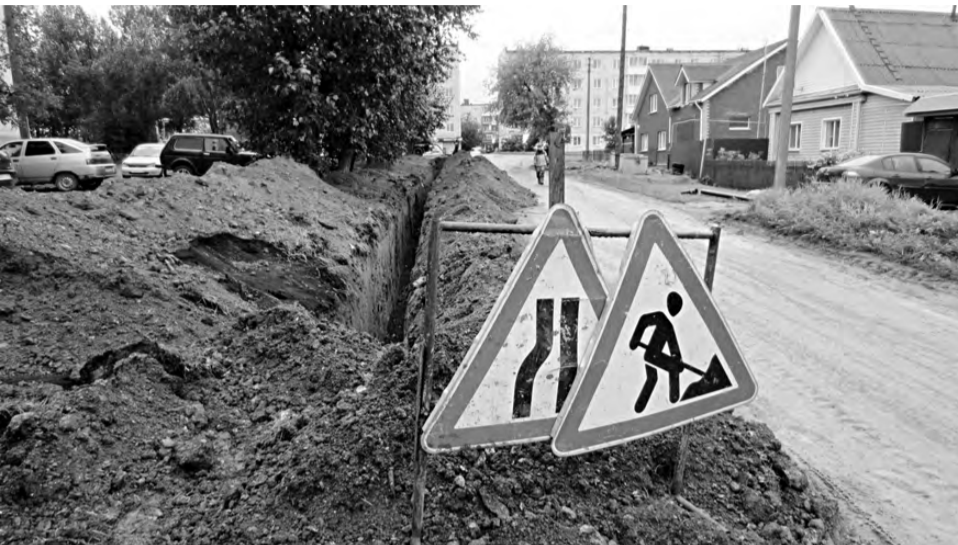
Ул. Трудовая: продолжается замена водопровода.
