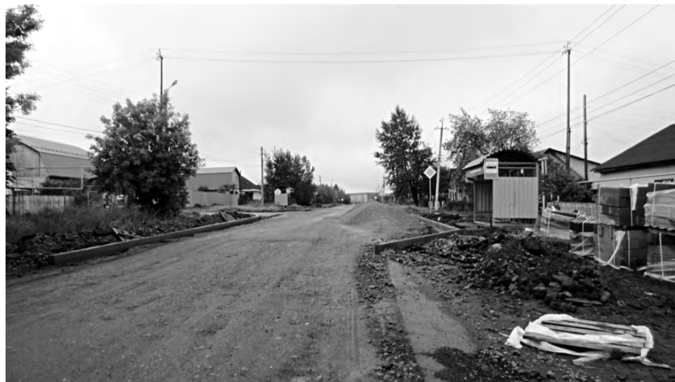
Ул. Зелёная: ремонтные работы идут по графику.
