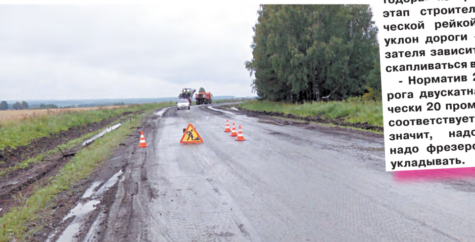
Идёт срезка старого асфальтового покрытия.
