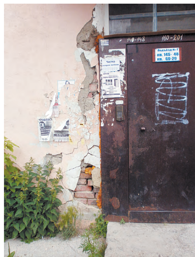
Из стены вот-вот вывалятся кирпичи.
